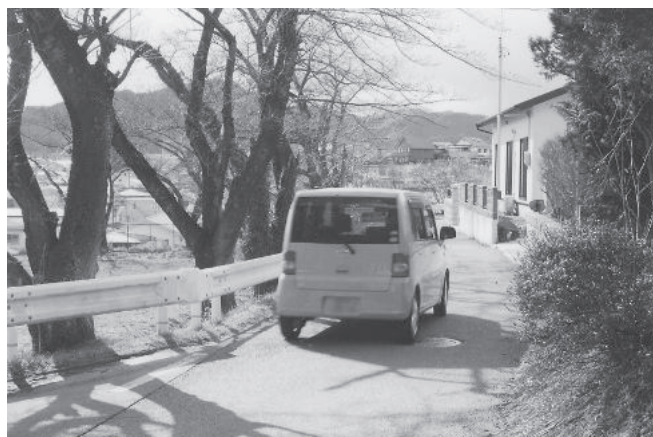
平成30年度に整備着手（本宮字館ノ越地内）
