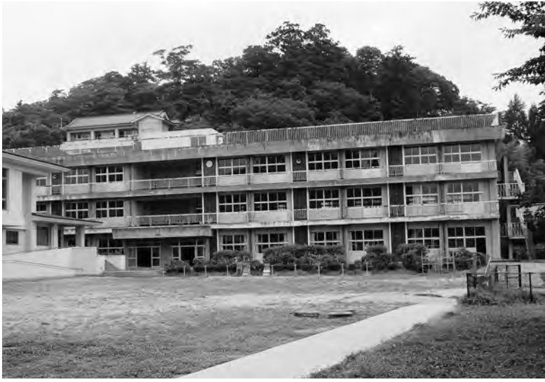
改修が始まる本宮小学校第2校舎
