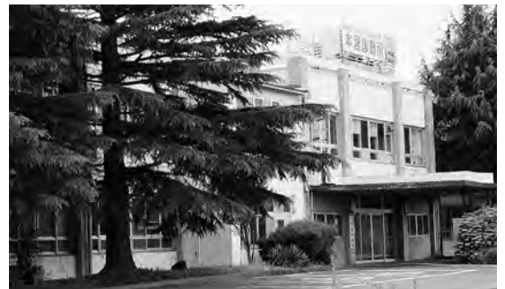
複合施設が建設される本宮診療所跡地
