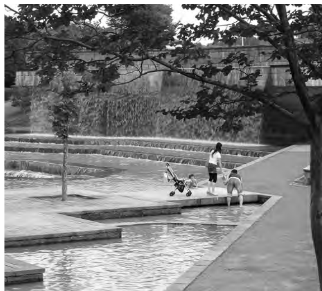
定期的に点検・清掃しています
