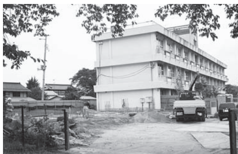
工事が進む岩根小学校
