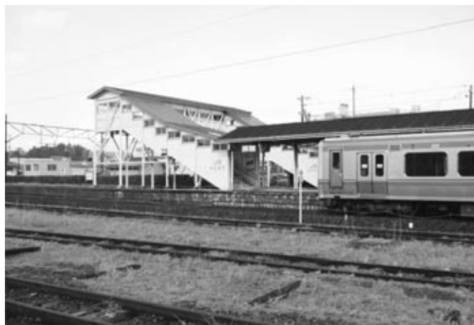
跨線橋を利用し西口からの乗り入れを
