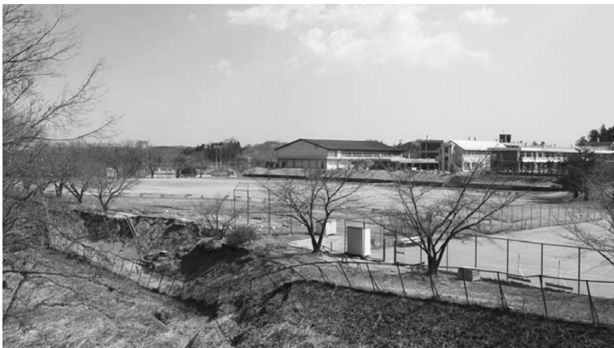
早期の復旧が待たれる白沢中学校の西側法面
