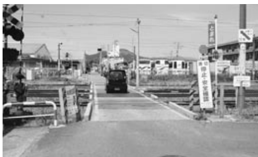
▲整備予定の大縄掘街道踏切
