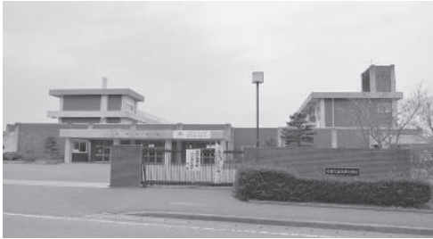
耐震化工事を予定している五百川小学校（上）と白沢中学校（下）
