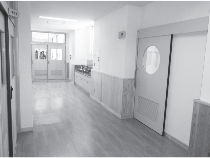
▲耐震補強改修工事を行った本宮第一中学校の北校舎
