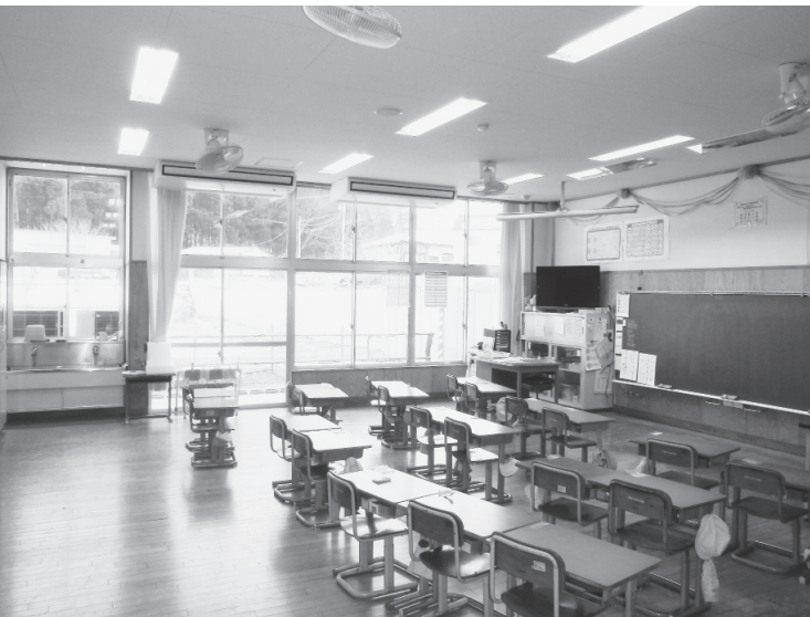
▲本宮まゆみ小学校の教室に設置されたエアコン
