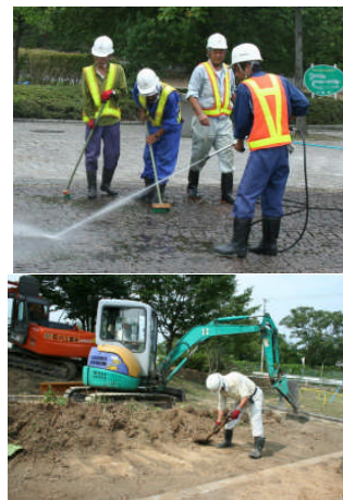
【写真上】高圧洗浄機を使用してインターロッキングを洗い流します。【写真下】重機や手作業で表土を取り除きました。
