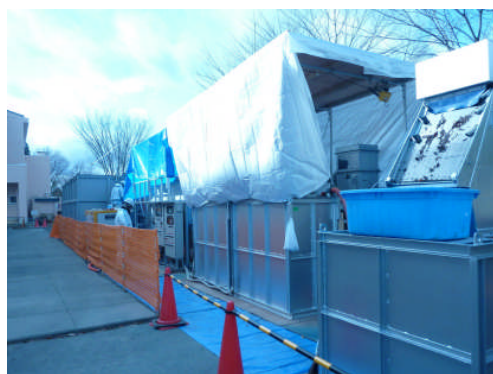
▲フェロシアン化鉄を利用した除染実証試験を実施したプラント
