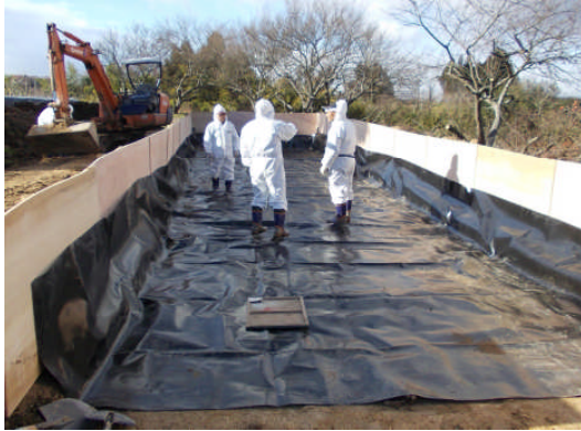
▲白岩地内で行われた国のモデル事業。遮水シートを敷き堆肥の一時保管場所を設営する様子
