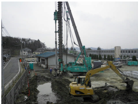
▲ 体育館の工事の様子
