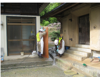
右上：除染作業の前後に線量を測定します 右下：コンクリート面などは高圧洗浄します 左上：足場を組むか、高所作業車を使って雨樋の拭き取りを行います
