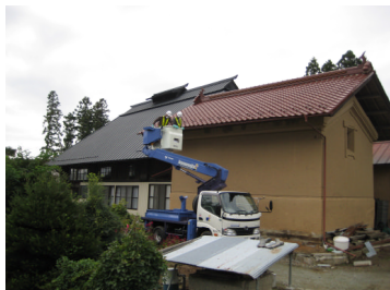
右上：除染作業の前後に線量を測定します 右下：コンクリート面などは高圧洗浄します 左上：足場を組むか、高所作業車を使って雨樋の拭き取りを行います
