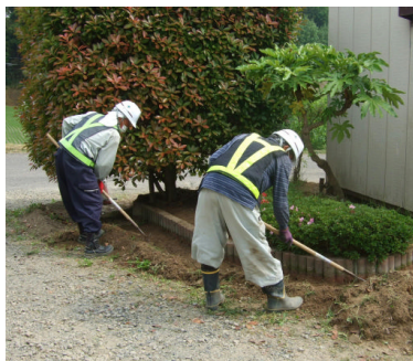
重機の入らない所は、手作業で除染します
