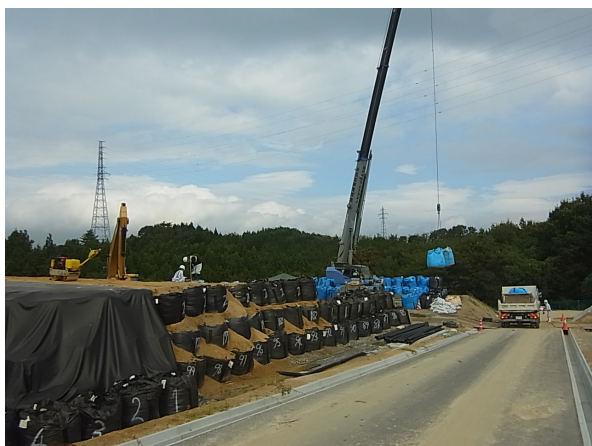
フレコンバッグの搬入が進む和田地区の仮置場
