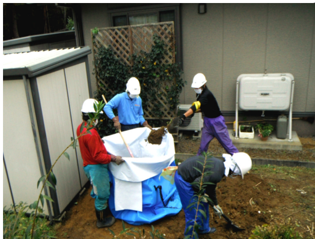
手作業による住宅除染の様子
