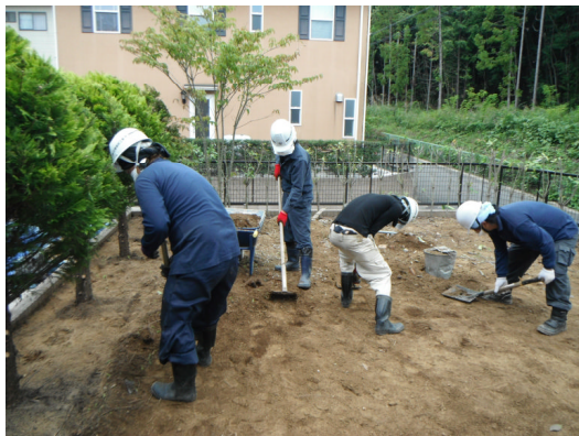
高木字井戸上地内の住宅除染の様子
