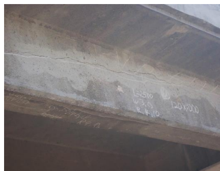
9.千代田橋：プレテンT桁橋 (橋長：32.60m、1954年竣工) プレテン桁の橋軸方向びびわれ・うき ※雨水の浸入により、損傷は進行する可能性が高い。(迂回路有り)
