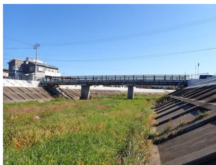
9.千代田橋：プレテンT桁橋 (橋長：32.60m、1954年竣工) プレテン桁の橋軸方向びびわれ・うき ※雨水の浸入により、損傷は進行する可能性が高い。(迂回路有り)
