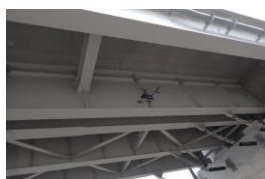
ドローンによる桁下の点検
