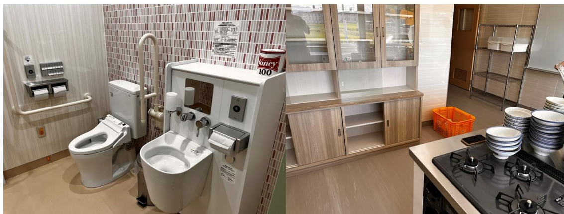
みんなのトイレ(新設)
