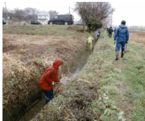
水路の泥上げ
