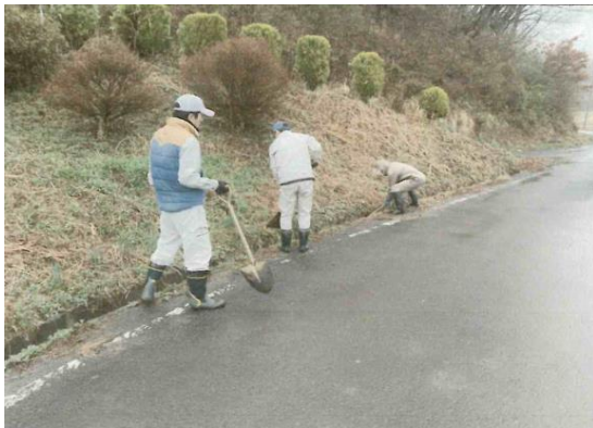
水路の泥上げ
