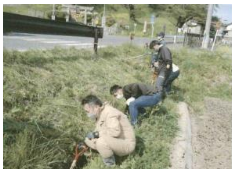
水路の泥上げ
