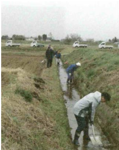
水路の泥上げ
