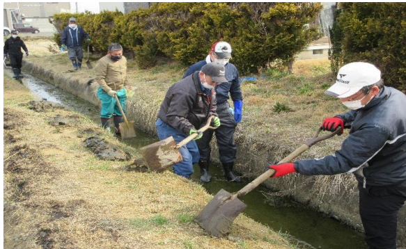
水路の泥上げ
