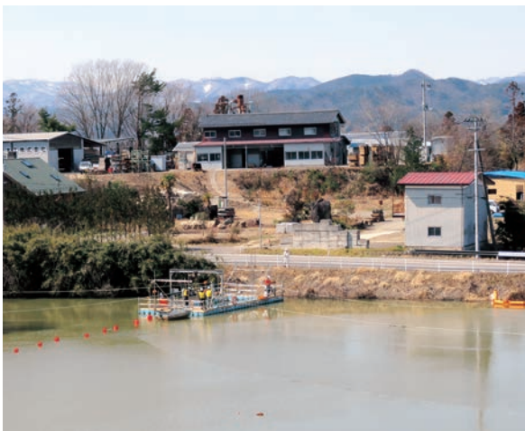
▲放射性物質対策工事中の重石池 （高木字重石地内）
