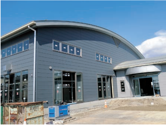
▲建設中の高木地区公民館（審査日現在） （高木字舟場地内）
